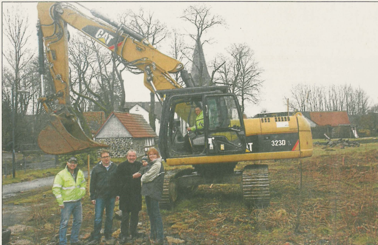
Nach dem erfolgten „ersten Spatenstich“ hoffen Markus Schrimpf, Thomas Kauck, Manfred Dickert und Silke Kauck (vorne von links) dass bis November 2013 die Bauarbeiten für das Pflegezentrum Grebenhain abgeschlossen sind. Baggerfahrer Sebastian Boß konnte sofort in Aktion treten, da gleich die ersten Lkws anrollten. Foto: Stock
